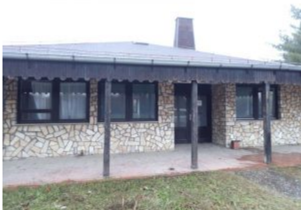
Objekat za smještaj beskućnika
